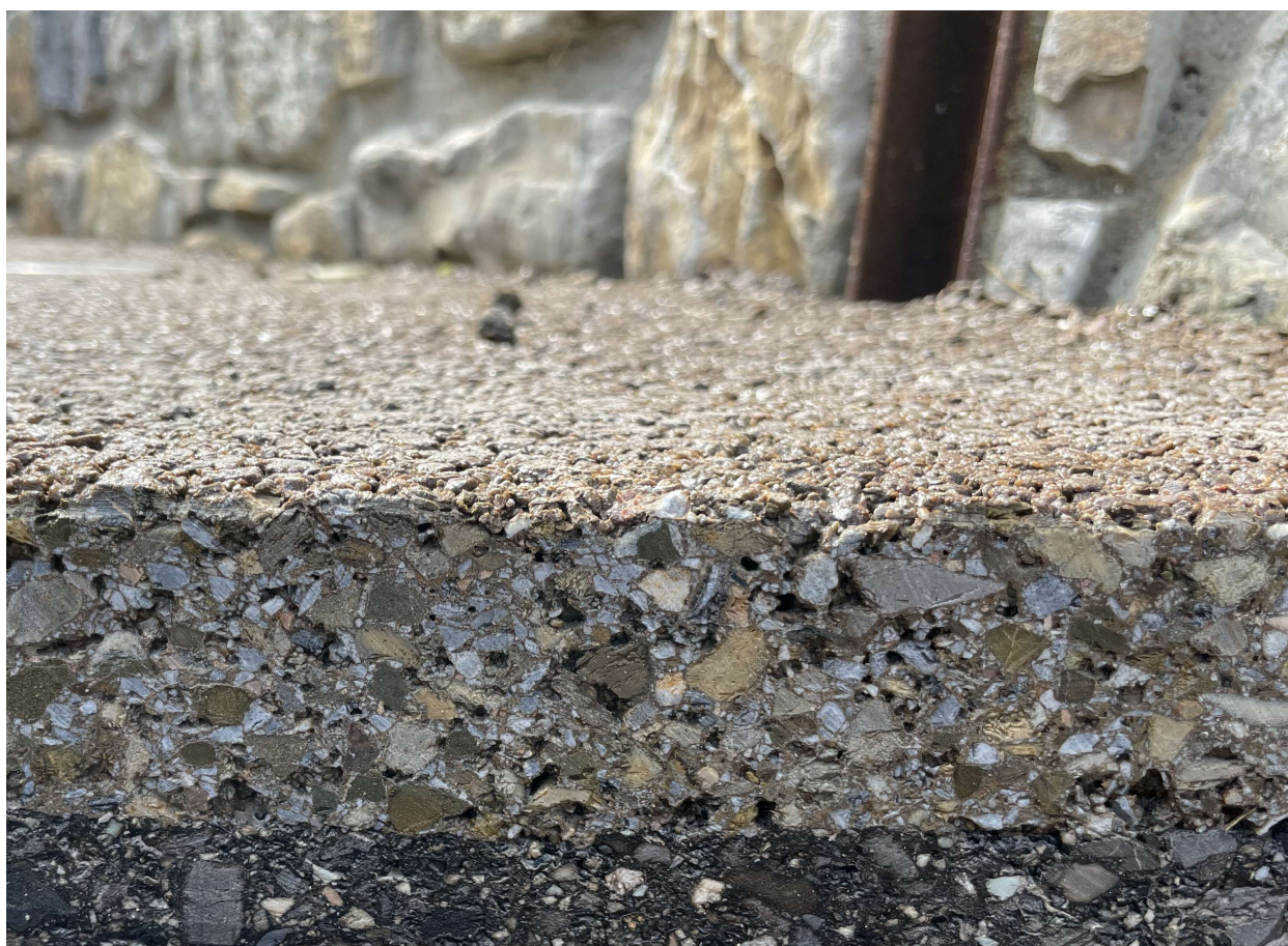
Foto 4 Sezione materiale posato
