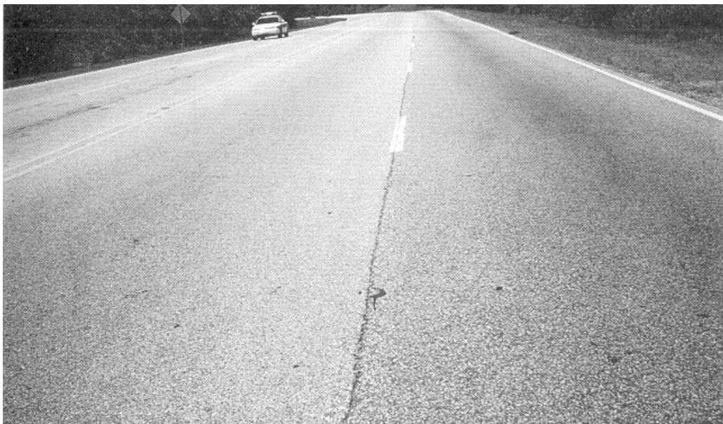
Figura 3: Fessurazioni longitudinali
